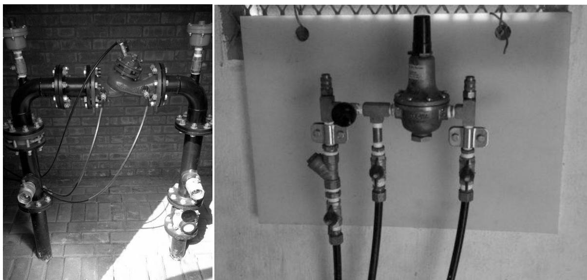
**Figura 4.-** Izquierda: Válvula Reductora de Presión (VRP). Derecha: Configuración de Salida Fija.
