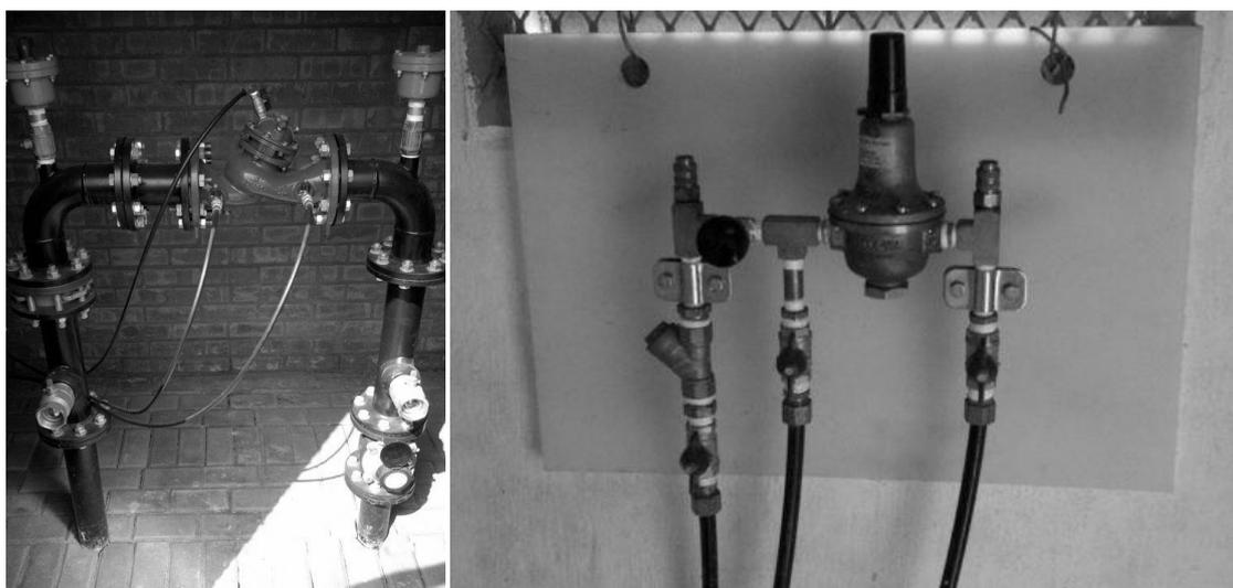
**Figura 4.-** Izquierda: Válvula Reductora de Presión (VRP). Derecha: Piloto de la VRP.
