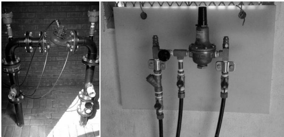
**Figura 4** - Válvula Reductora de Presión (VRP) instalada por JOAT Group en Durban, Sudáfrica. A la izquierda se ve la instalación finalizada de la VRP. A la derecha se muestra el piloto con una configuración de salida fija.
